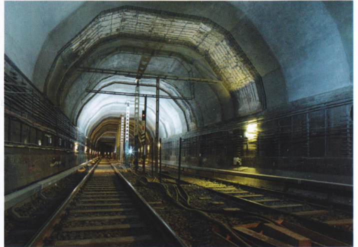
Tunnelsanierung in Berlin: U6, Tempelhofer Damm
